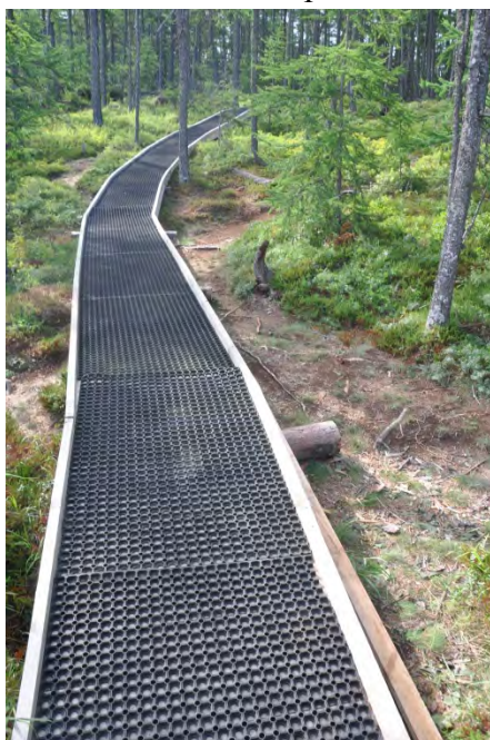
Рис. 7 и 8. Резиновое покрытие уложено на полотно тропы и смотровую площадку.
