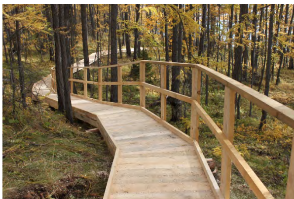
Рис. 3 и 4. Готовый деревянный настил и настил-пандус с перилами на экотропе.
