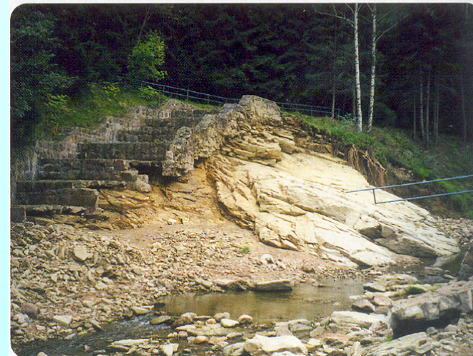
Abbildung 7-5: Dammbrechestelle nach dem Hochwasser (Foto: LTV, 2002)
