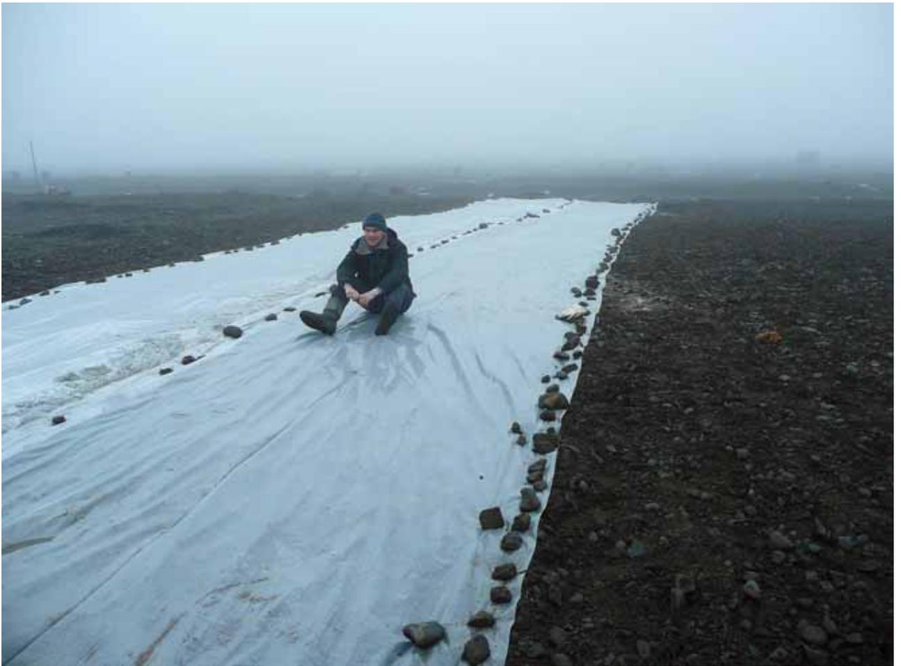
Рис. 6.3.11. Участок полигона № 2, обработанный биопрепаратом «Деворойл», и укрытый дышащим полиэтиленом.
