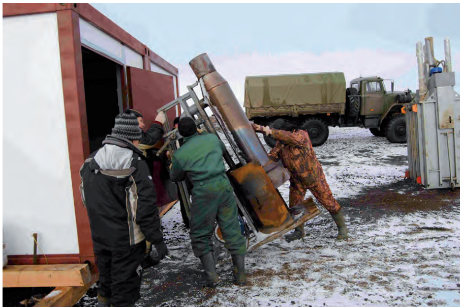
Рис. 23. Монтаж печи для выжигания остатков ГСМ и прессы для прессования стальных бочек
