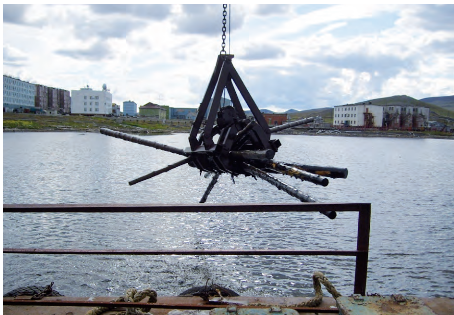
Рис. 18. Очистные работы: подъем затонувшей древесины со дна бухты
