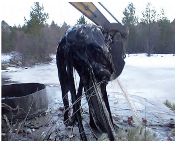
Рис. 19. Сбор и погрузка нефтепродуктов из нефтехранилища
