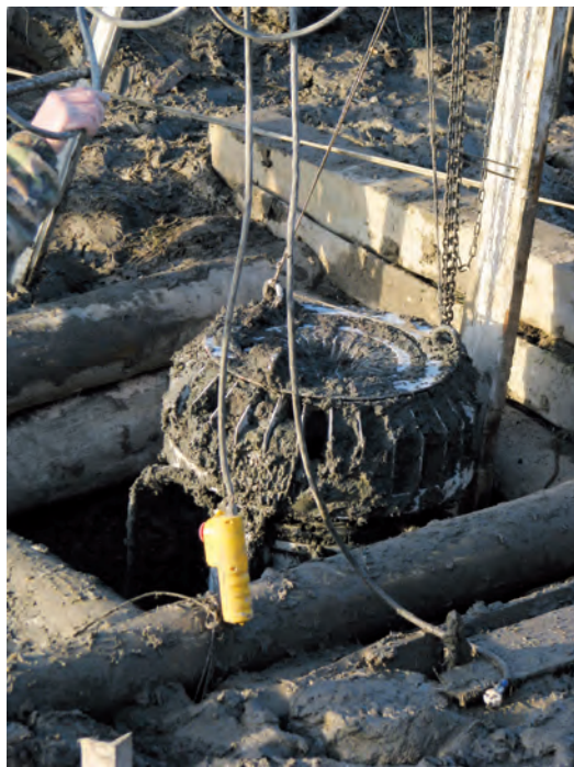
Рис. 33. Извлечение РИТЭГа из термокарстовой воронки
