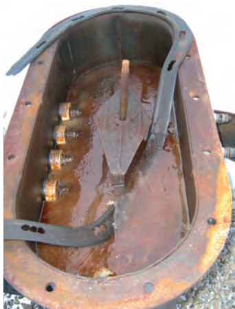
Рис. 41. Брошенный трансформатор – возможный источник ПХБ
