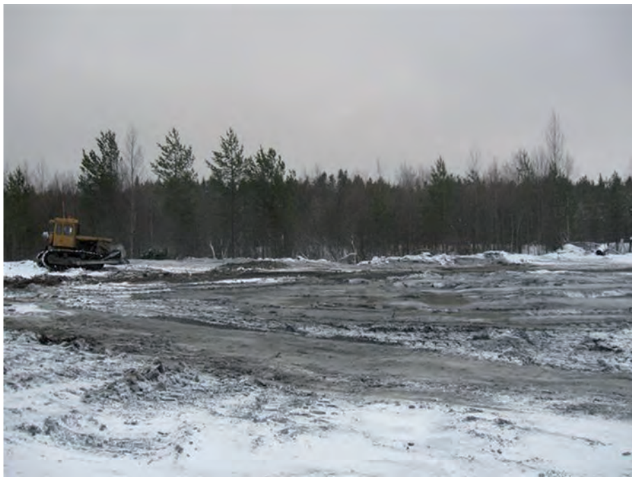
Рис. 21. Общий вид склада нефтепродуктов (нефтехранилища), расположенного в пос. Покровское Онежского района после завершения планировочных работ
