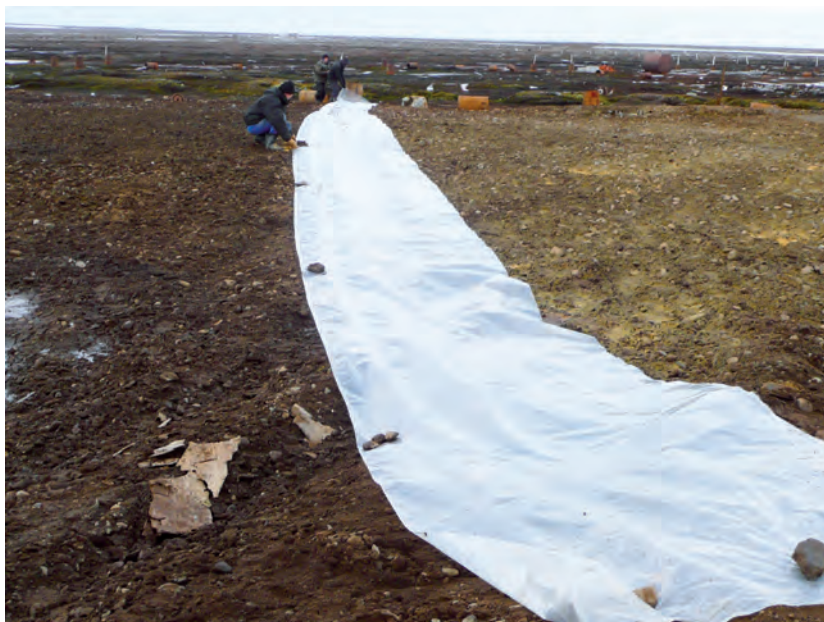
Рис. 6. Рекультивация загрязненного нефтепродуктами грунта и обработка биопрепаратом
