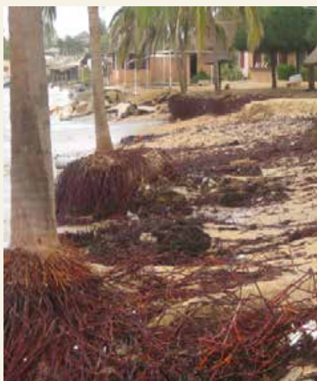
Le problème de l'érosion côtière à Saly, Sénégal (Photo: Projet COAST)
