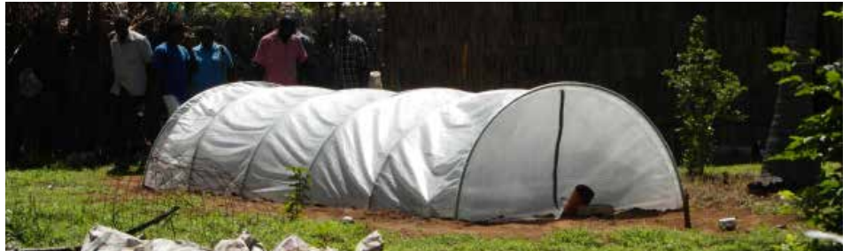
Système de flexy biogaz installé dans l'association Watamu Marine Association au site de démonstration de Watamu, Kenya (Photo: Projet COAST)
