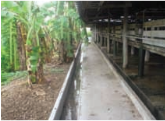
รูปที่ 3-4 รางรับน้ำเสียจากโรงเรือน
