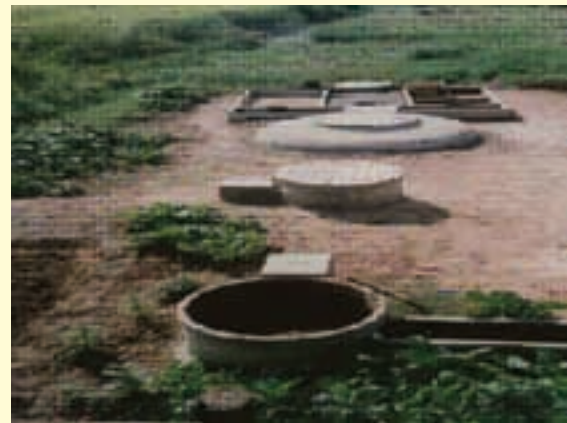
รูปที่ 3-11 บ่อหมักแบบโดมคงที่ (Fixed Dome)
