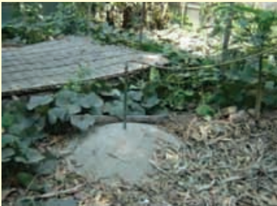
รูปที่ 3-11 บ่อหมักแบบโดมคงที่ (Fixed Dome)
