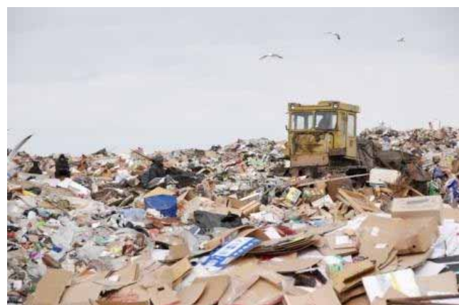
Фото 4. Разравнивание отходов трактором
