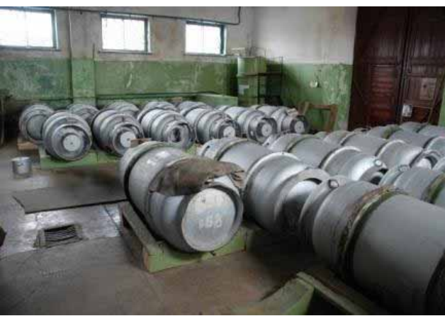
Фото. 6. Склад хлора в контейнерах
