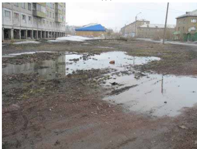
Фото 9. Участок территории Железнодорожного района, по которой проложена канализация
