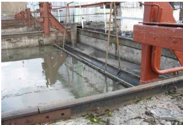
Фото. 7. Первичные горизонтальные отстойники с устройством для сбора плавающих загрязнений
