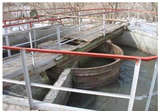
Фото. 5. Песколовка с круговым движением воды
