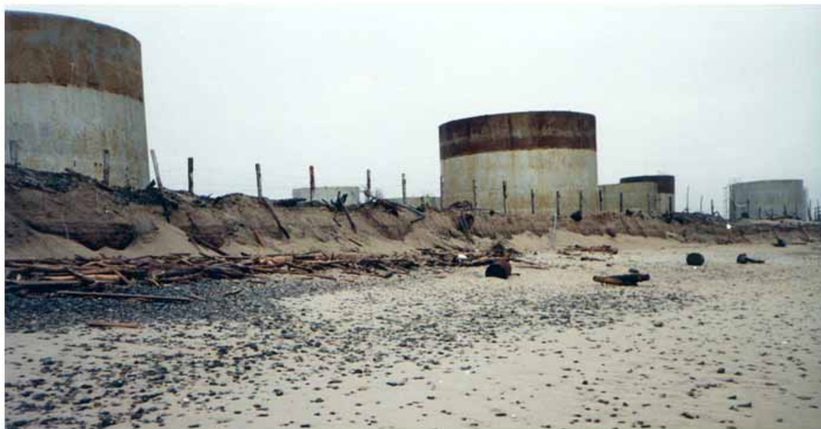
Рис. 5. Термоабразия берегов с инженерными сооружениями (фото С.А. Огородова)
