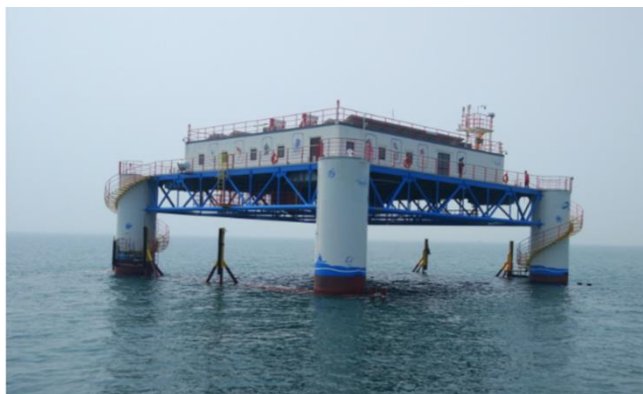
图1 半潜式海洋牧场平台
